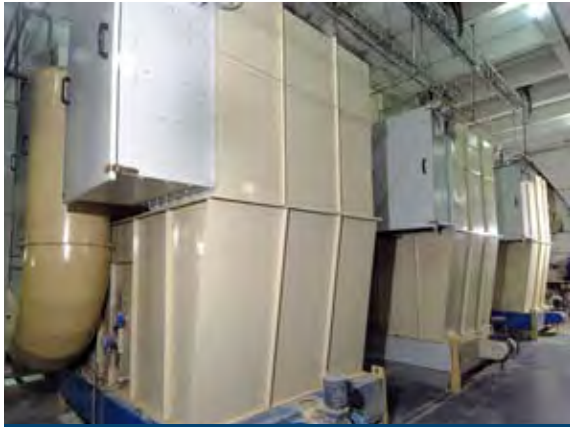
Enfriadores verticales a contracorriente
