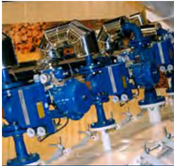
Batería vapor sobre CPID 700
