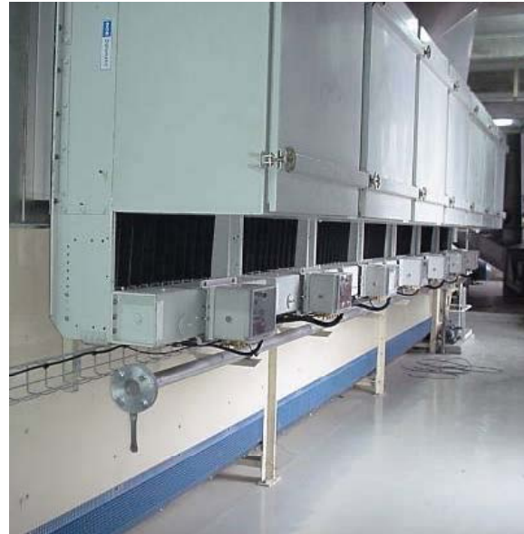
Enfriador de 2 pasos equipado con filtros
