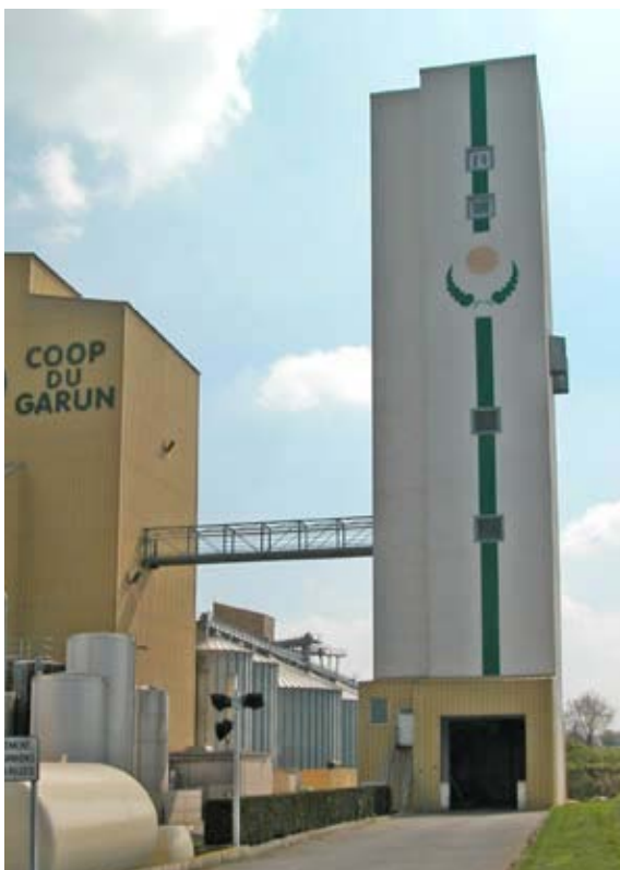
Torre de tratamiento térmico « COOP DU GARUN, France » totalmente aislada para suprimir los riesgos de contaminación
