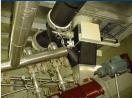
Conexión rosca- acondicionador
